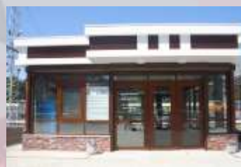
Май 2016. Установка дополнительного турникетного комплекса на ст. Сеятель.
