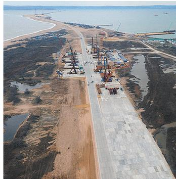
грунт считается наиболее благоприятным для строительства, поэтому работы должны пойти быстрее. Сейчас уже готовы железобетонные свайные поля для установки опорных конструкций моста. Технология строительства учитывает все риски, связанные с особенностью рельефа дна в заливе.
